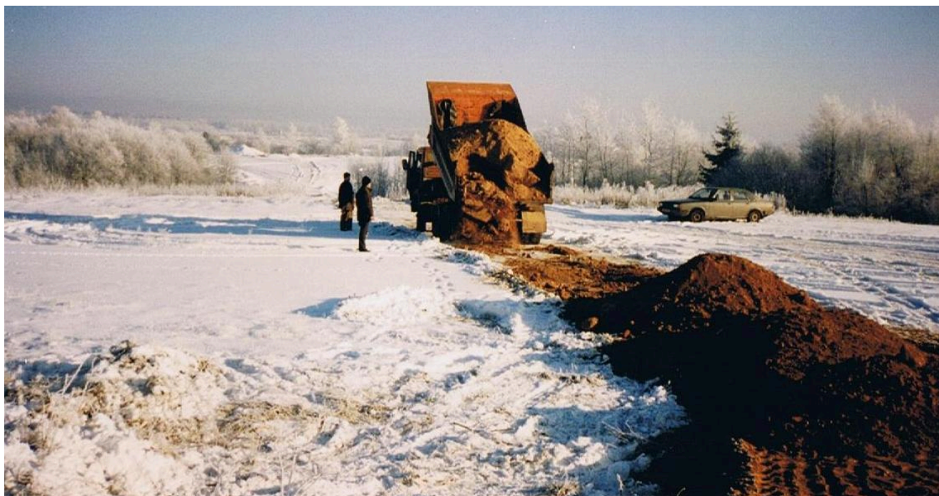
Начало строительства, устройство дороги, 1995 г.
